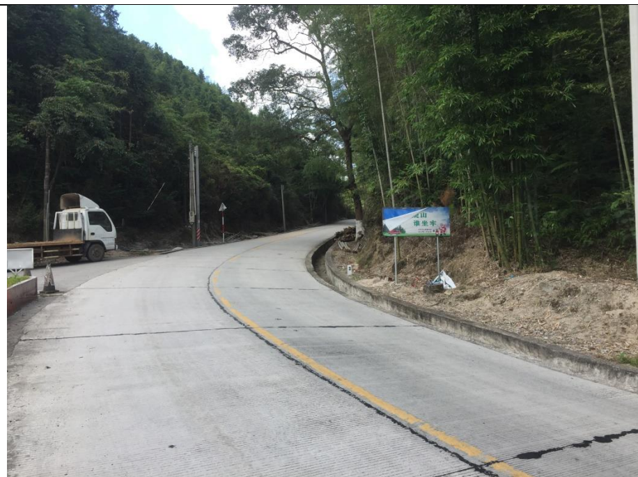
拟改建道路现状
