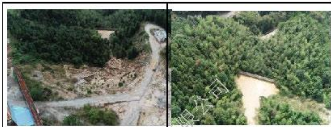
图4 废石堆场现状照片
