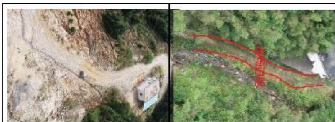
图 6 进厂道路区现状照片
